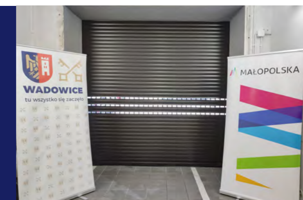
OSP Jaroszwice – wymiana bramy garażowej w budynku remizy
